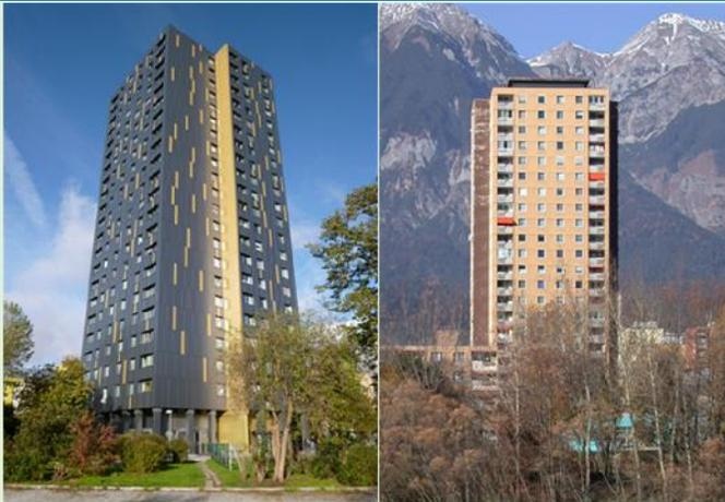
In diesem Wohnhochhaus wurden im Rahmen der Sanierung die Loggien thermisch geschlossen und in erweiterte Wohnräume und Wintergärten umgewandelt. Alle Fenster wurden ausgetauscht und sind durch Holz-Alu-Fenster mit 3-Scheibenverglasung ersetzt worden. Die Spezialkonstruktion des Außenwandaufbaues der VÖEST wurde mit 16 cm Mineralwolle zusätzlich gedämmt, Windpapier und 4 cm Hinterlüftung sowie 4 mm Alucopond-Paneele kompletieren den Fassadenaufbau.
